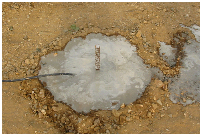
Micropalen zijn palen met een kleine diameter maar met een relatief grote draagkracht.
