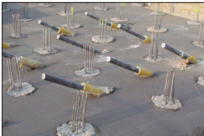
Micropalen zijn palen met een kleine diameter maar met een relatief grote draagkracht.
