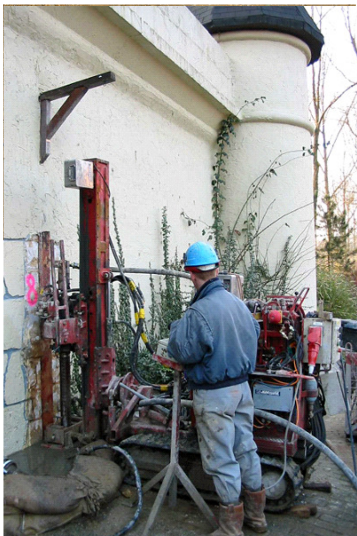
Micropalen zijn palen met een kleine diameter maar met een relatief grote draagkracht.
