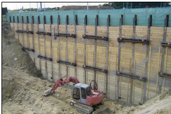
Een Berlinerwand of Berlijnse wand is een grondkerende constructie.
