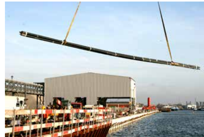
Staafankers met een diameter van 75 TR wegen 35 kilo per meter, wat voor de grootste exemplaren neerkomt op een gewicht van 1,155 ton per anker.
