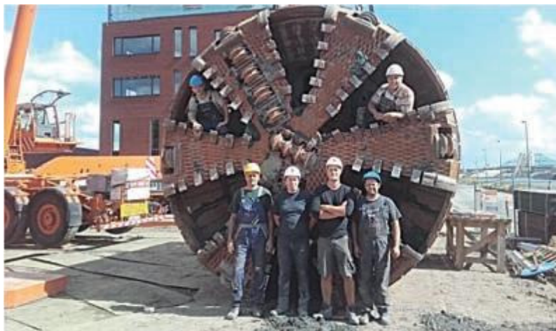
Le micro-tunnelier et l'équipe après l'achèvement du fonçage. The micro-tunneller team on completion of drilling.
