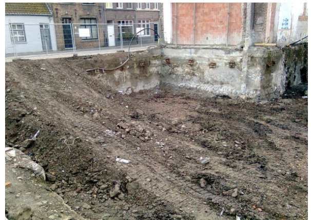
Beschoeiing bouwput d.m.v. verankerde VHP-palenwand en VHP-lamellenwand.
