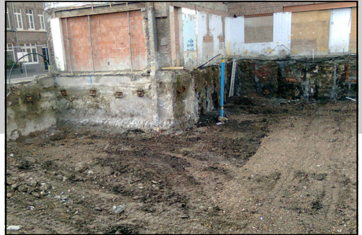
Beschoeiing bouwput d.m.v. verankerde VHP-palenwand en VHP-lamellenwand.
