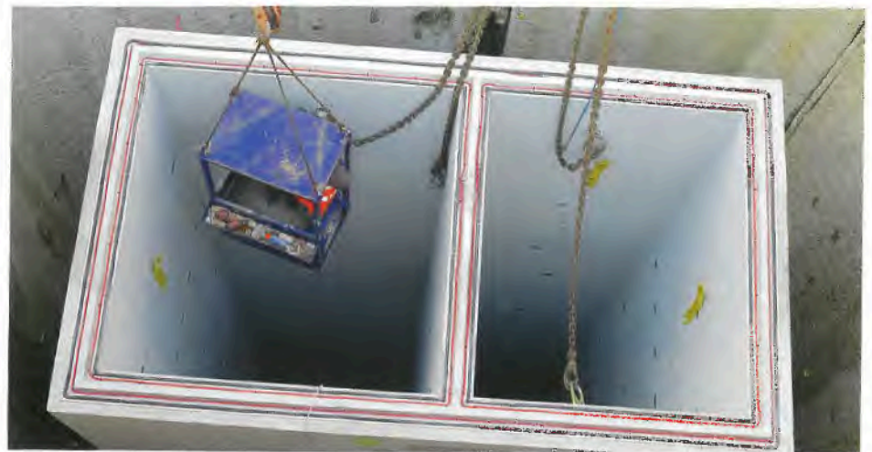
Montage des Justier- und Führungssystems zum lagegenauen Setzen der Schachtfertigteile. Eine speziell für diese Baumaßnahme entwickelte Dreifachabdichtung sichert die mit 26 Metern Wassersäule beaufschlagten Fugen.
