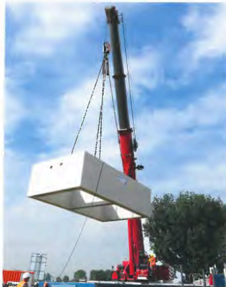
Ablassen der Doppelkammer-Fertigteile mit rd. 44 t Einzelgewicht in die Schlitzwandbaugrube. Das Fertigteilwerk hatte in Anlehnung an das Konzept der Düker-Vortriebsrohre eine SW-Beton-Rezeptur erarbeitet.
