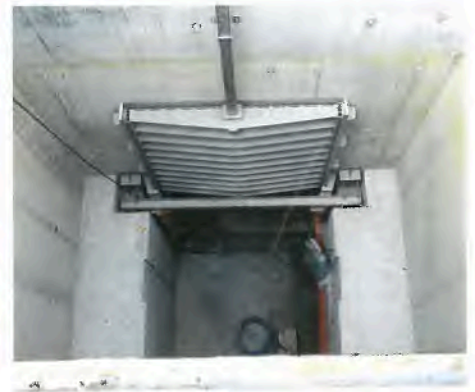
Fotos links und oben: Parallel zum Vortrieb und Schachtbau wurden die unterirdischen Verbindungsbauteile vom noch in Betrieb befindlichen Düker zum neuen Abwasserkanal realisiert und mit entsprechenden Schiebern ausgestattet
