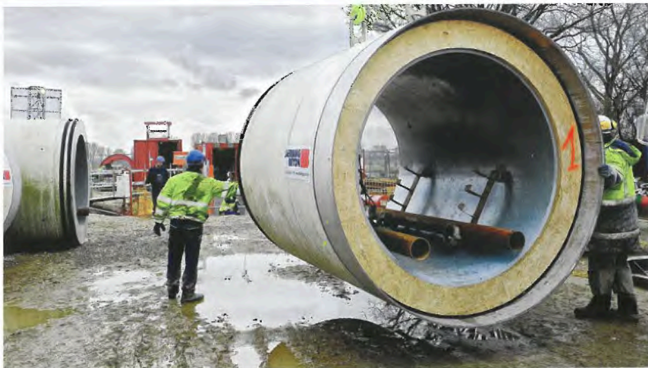
Über 250 Stahlbeton-Vortriebsrohre wurden im Werk mit Innenimprägnierung, vormontiertem Druckübertragungsring und Doppeldichtungssystem ausgestattet. Die Anlieferung fand unter Berücksichtigung der eingeschränkten Baustellen-Lagersituation nach einem festgelegten Logistikkonzept statt.
