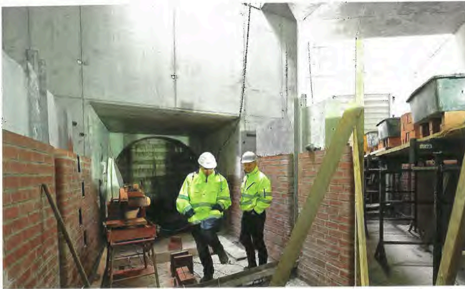
Fotos links und oben: Parallel zum Vortrieb und Schachtbau wurden die unterirdischen Verbindungsbauteile vom noch in Betrieb befindlichen Düker zum neuen Abwasserkanal realisiert und mit entsprechenden Schiebern ausgestattet
