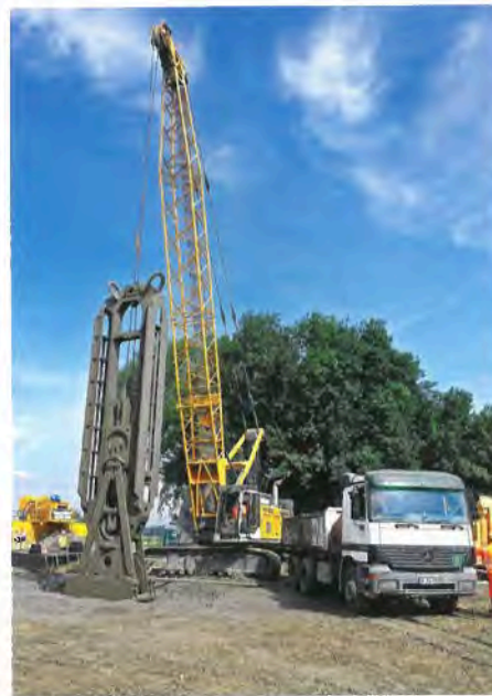
Schweres Gerät im Einsatz, um die Schlitzwände für die Startbaugrube bis in eine Tiefe von 47 m zu erstellen.
