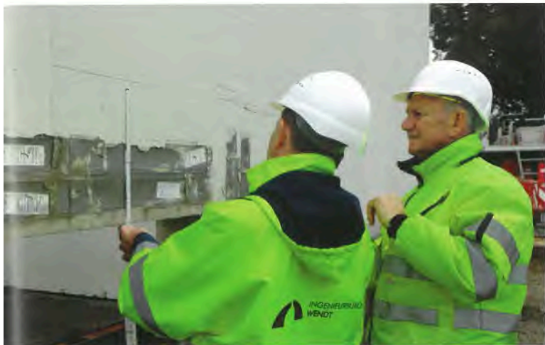
Abnahme der Anschlussbewehrung und Qualitätsprüfung der Fertigteile durch den Bauherrn SEBD und Mitarbeiter des Ingenieurbüros Wendt
