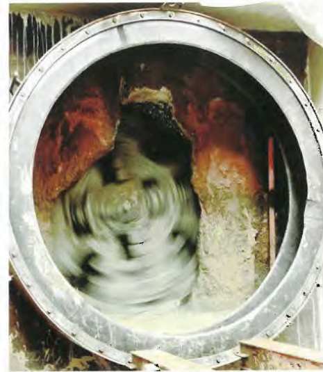
Das rotierende Schneidrad der Vortriebsmaschine nach einem Kilometer Vortriebsleistung unmittelbar an der Einfahrdichtung der Zielbaugrube.
