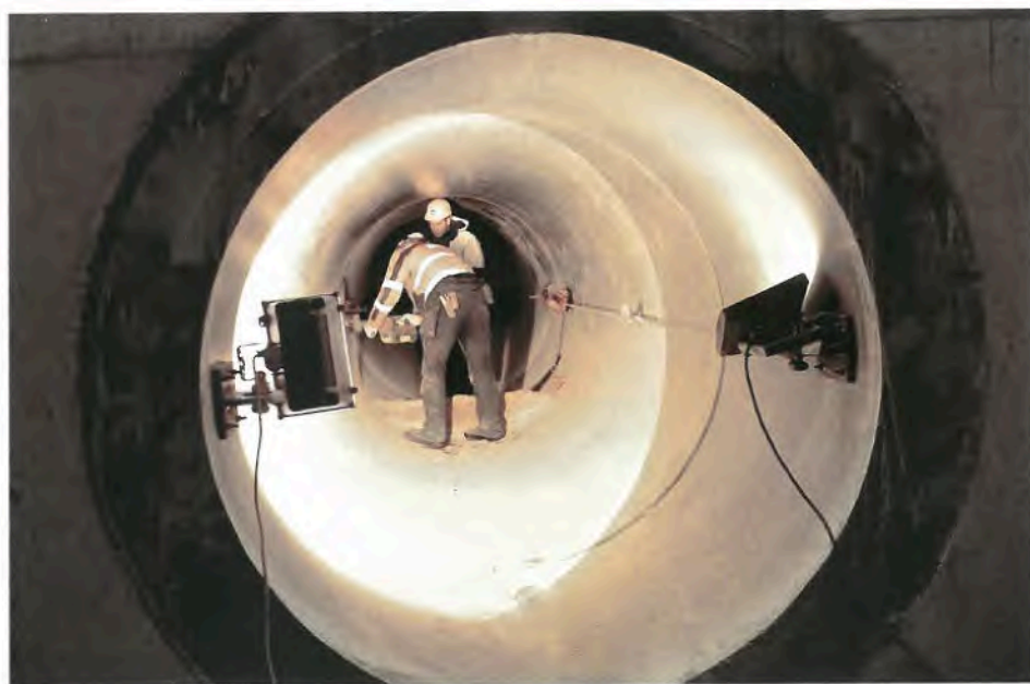
Wasserdichtheitsprüfung der Rohrverbindungen nach abgeschlossenem Vortrieb, ohne hohen Aufwand ermöglicht durch das Doppeldichtungssystem bestehend aus zwei in einzelnen Betónkammern fixierten Lippengleitdichtungen und dazwischen liegenden Prüfröhrchen aus Edelstahl.
