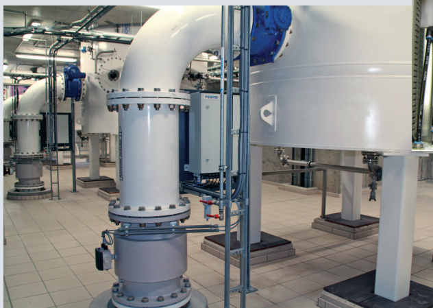
Festo leverde ready-to-install kasten met VTUB ventieleilanden als onderdeel van de elektropneumatische sturing.
