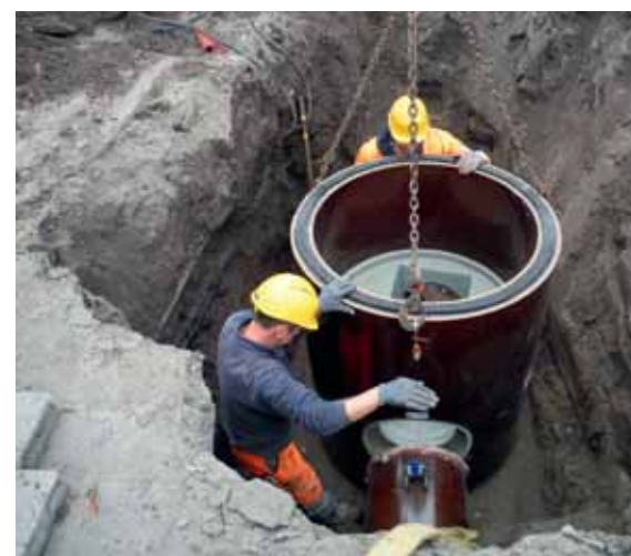
Recent werden op Brugs grondgebied ook 80 gres inspectieputten van Steinzeug-Keramo geïnstalleerd. (foto Steinzeug-Keramo)
