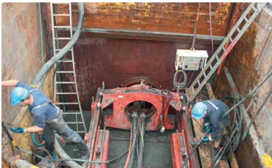
De kringsput (5 meter op 5) van waaruit de gresbuizen DN 800 mm worden doorgeperst.
