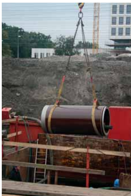
Gres doorpersbuis die wordt neergelaten in de startput.
