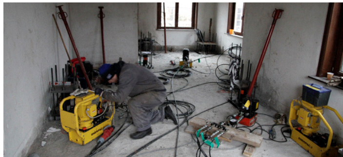
Des injections peuvent être réalisées pour remplir les cavités et les pores du sous-sol.
