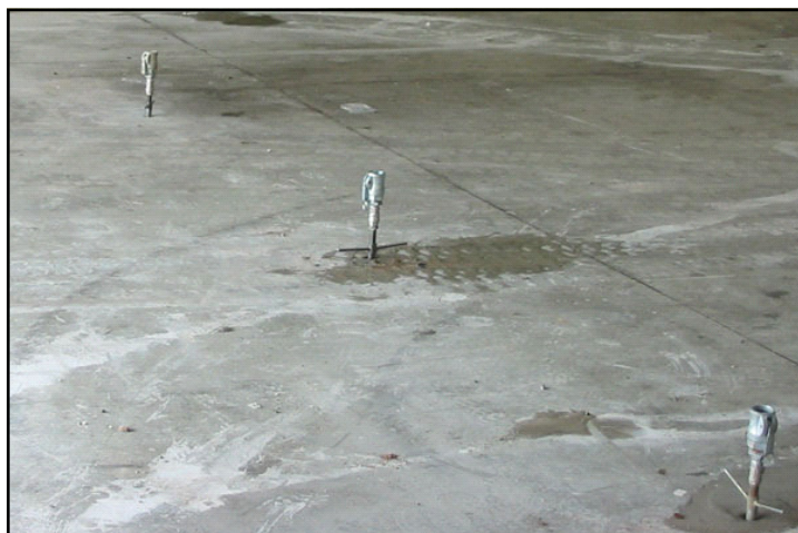
Des injections peuvent être réalisées pour remplir les cavités et les pores du sous-sol.
