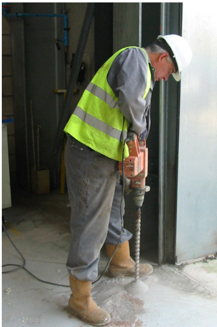
Des injections peuvent être réalisées pour remplir les cavités et les pores du sous-sol.
