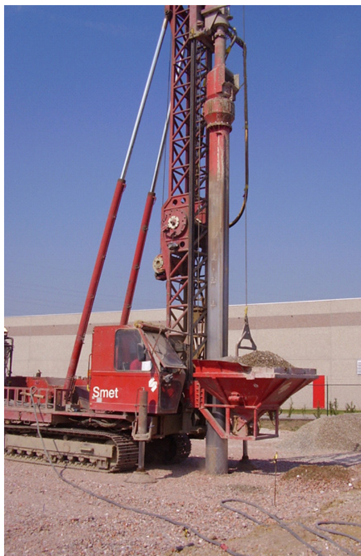
Colonnes ballastées qui servent de fondation pour une dalle de plancher.
