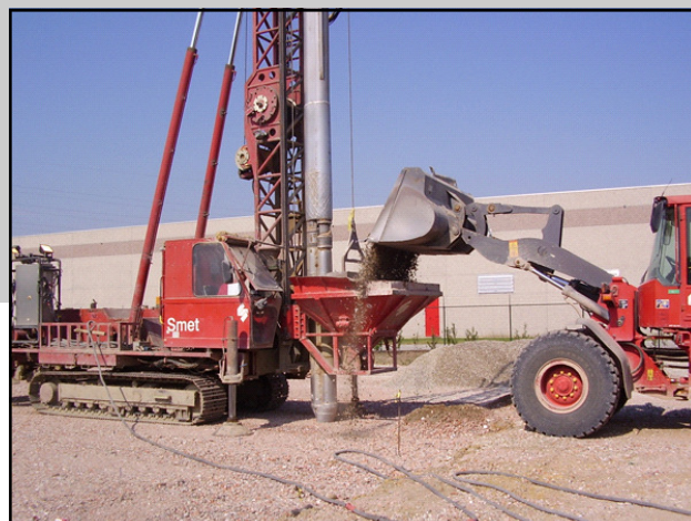
Colonnes ballastées qui servent de fondation pour une dalle de plancher.
