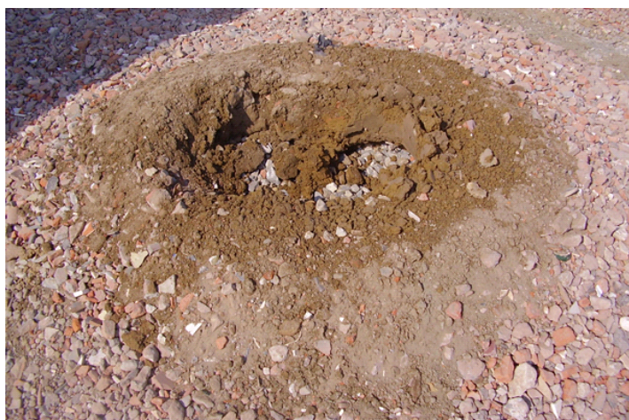
Colonnes ballastées qui servent de fondation pour une dalle de plancher.
