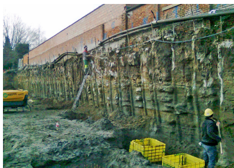
Verankerde VHP-onderschoeiing als beschoeiing van de bouwput.
