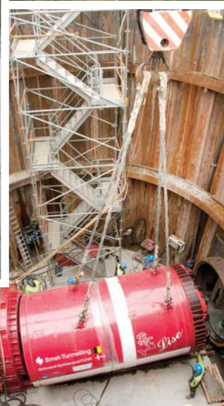
Sættning af "Lise" i startgrube B3
