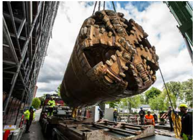
Recent is het diameterbereik van horizontale doorpersingen sterk uitgebreid, zowel naar onder (400 mm) als naar boven toe (3500 mm).
