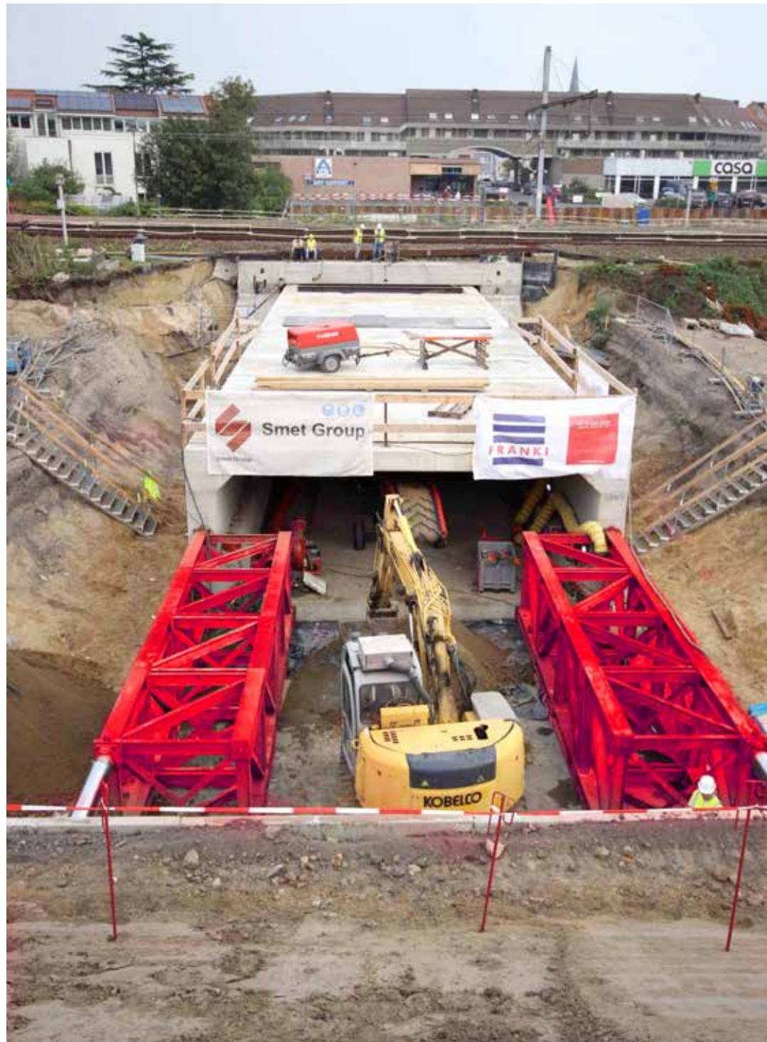
De tunnel zelf werd door Franki Construct prefab op de site zelf gebouwd en vervolgens door Smet Group in de schacht geschoven.
