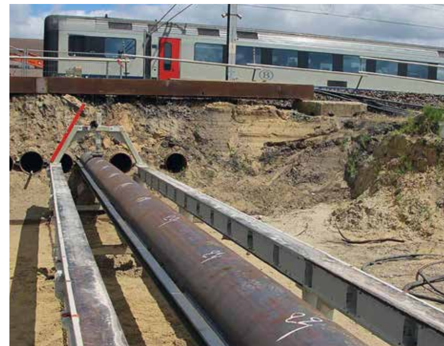
Om de tunnel te bouwen werd onder de sporen eerst een buizendak en vervolgens een betonnen koker van 9,20 meter breed en 3,85 meter hoog geschoven.
