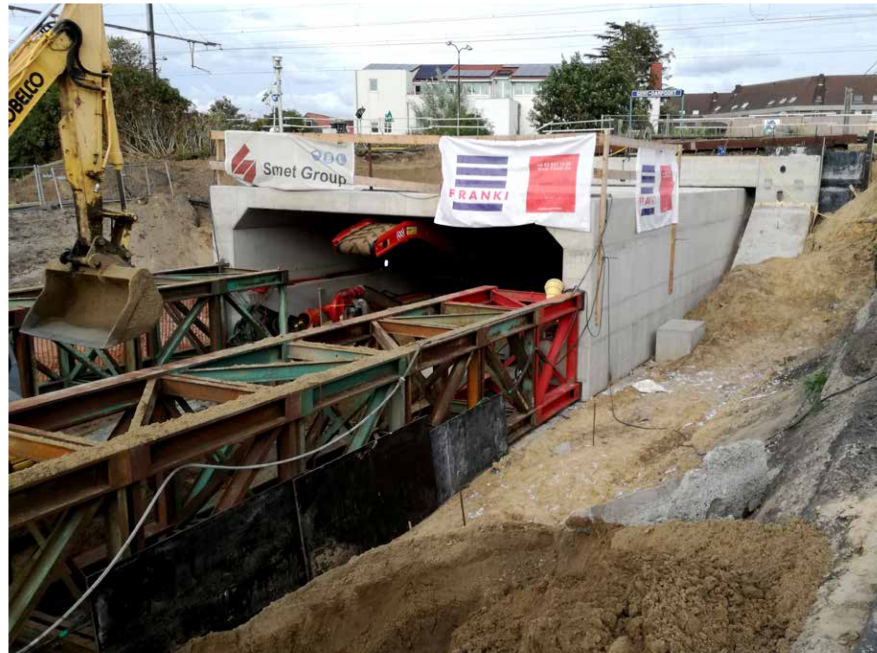
De Dampoorttunnel is een veiliger en sneller alternatief voor het drukke rondpunt aan de Dampoort en voor de route langs de Forelstraat.
