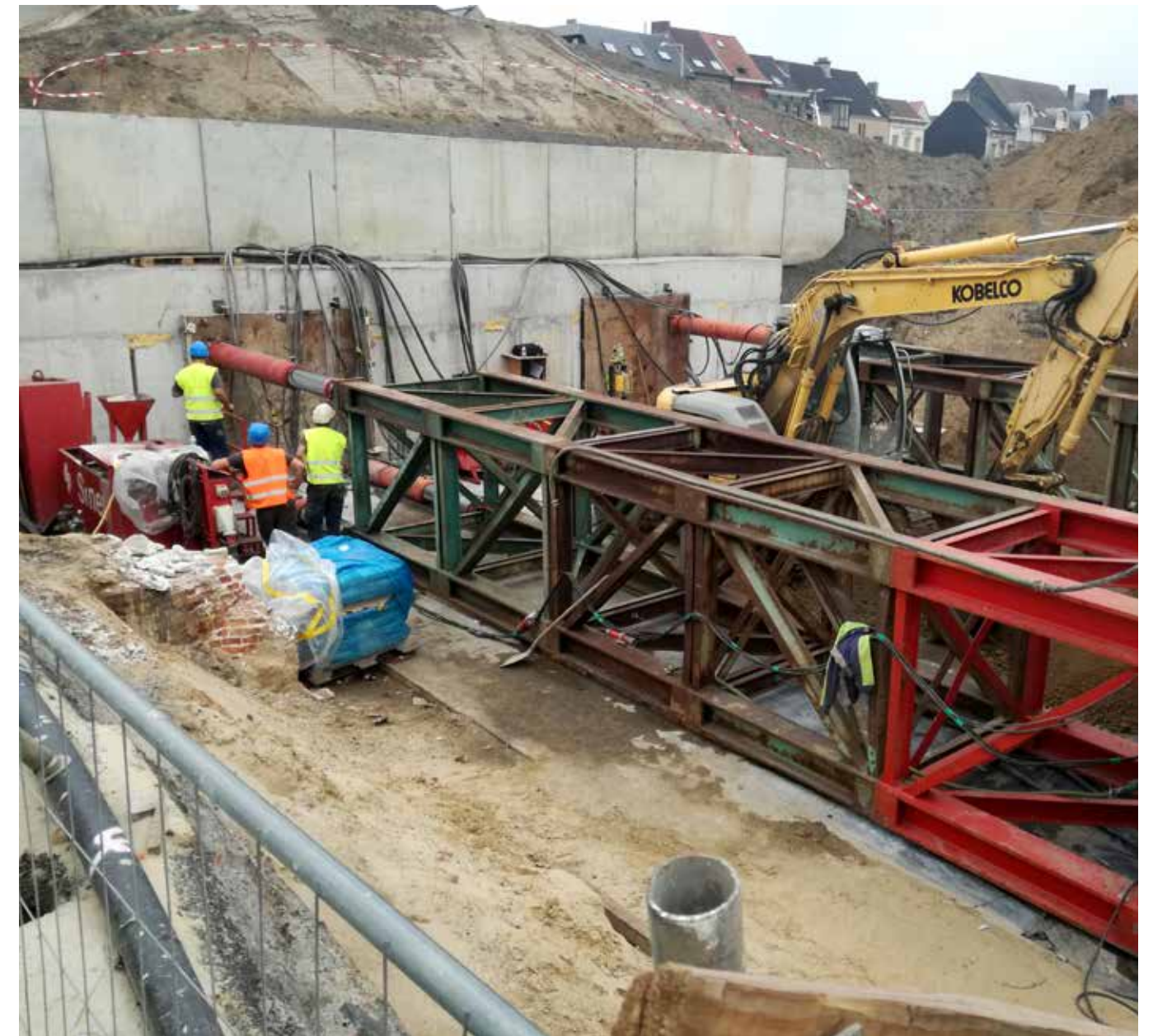
De tunnel onder de sporen is ongeveer 30 meter lang, 6 meter breed (2 meter voetpad en 4 meter fietspad) en 2,70 meter hoog.
