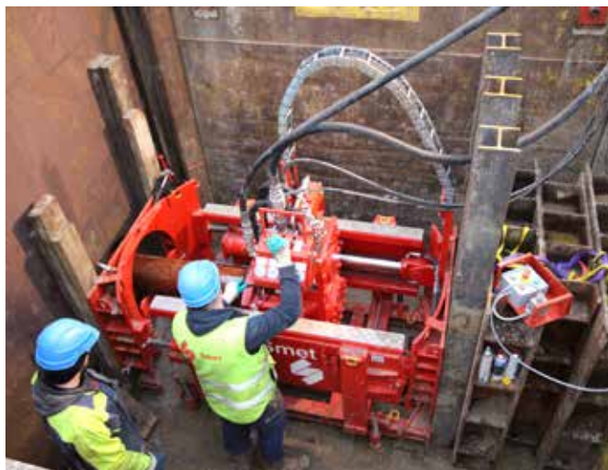
De productbuis wordt doorgedruwd vanuit de vertrekschacht.
