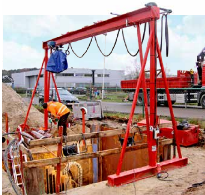
Op het industrieterrein in Malle realiseert Smet Group de volledige rioolrenovatie.
