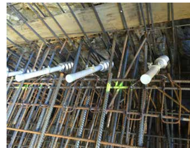
Vloeranker B26 is een van de zwaarste vloerankers op de markt
