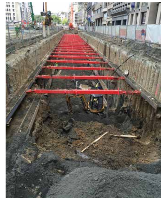
In de tunnels wordt gebruik gemaakt van eenzijdige bekisting.
