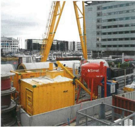
Die Suspensionsmischanlage SKC-60-C wird mittels Förderschnecke aus dem (roten) Silo beschickt. Hinter der Mischanlage steht der Rührwerksbehälter ST-V26 zur Zwischenspeicherung der angemischten Bentonitsuspension.
