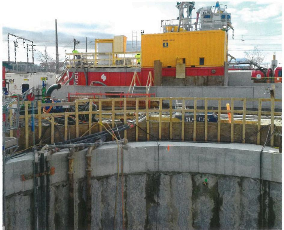
Startschacht der Vortriebsmaschine. In den Schacht führen die Förder- und Speiseleitung der Vortriebsmaschine. | Fotos: MAT
