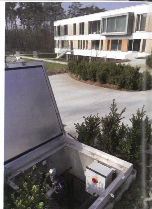
Warmte en koeling zijn onbeperkt beschikbaar dankzij een geothermische warmtepomp (grondwater) met verticale captatie en KWO.
