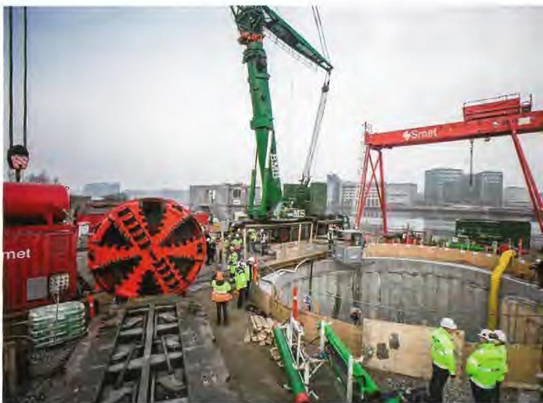
Het vergt circa drie weken om alle benodigde materialen te installeren.
