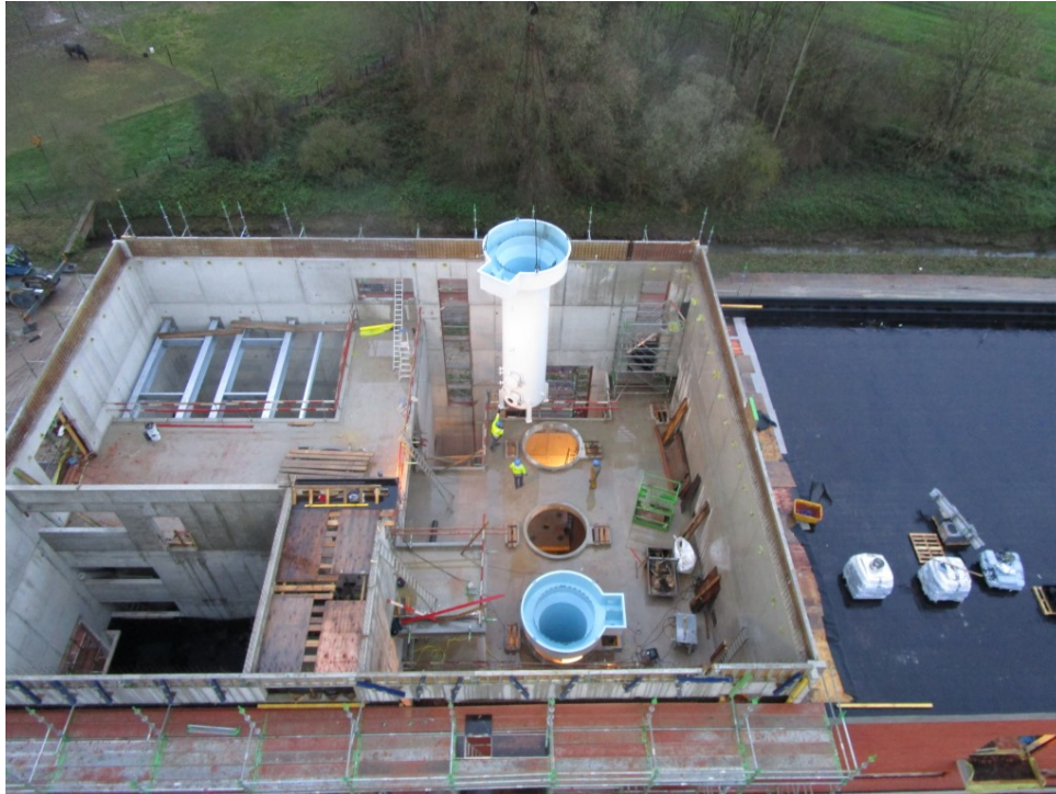
Bouw van een nieuw waterproductiecentrum te Velm – Sint-Truiden (ontharding met korrelreactoren + open filters + HD-pompenzaal) – Foto: Smet Group
