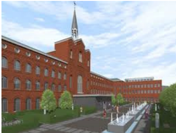
Sint-Vincentius Ziekenhuis Antwerpen. Smet zorgde hier voor goedkope verwarming en koeling met warmtepompen en koude-opslag
