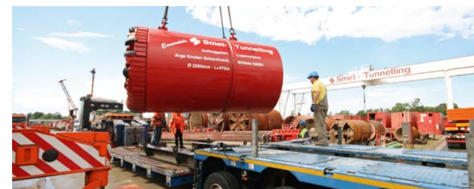
Laden van het boorschild in Dessel
