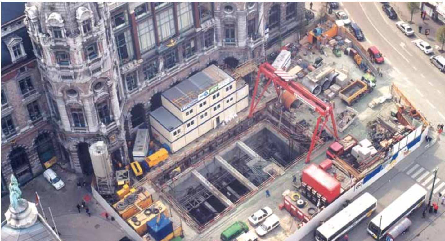
Boren onderdoorgang Antwerpen Centraal Station.
