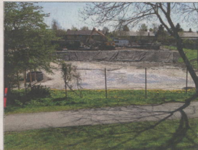
Den ene ende af den planlagte tunnel overfor VP-arkaderne, hvor boremaskinen på tres ton snart sænkes ned. Herfra arbejder den sig frem mod ledningens anden ende og skat ved spildevandsanlægget på Skovgaardvej.
