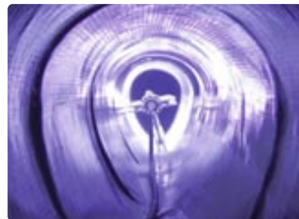
De rioolrenovatie in Evere wordt uitgehard met uv-licht.
