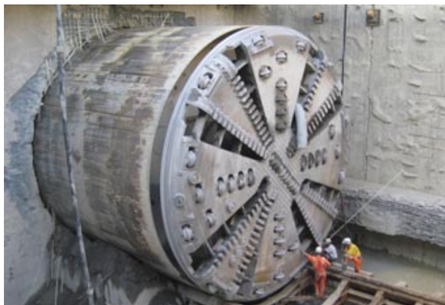
Een boorkop heeft net de ruimte vrijgeboord voor de hogesnelheidslijn onder de luchthaven van Zaventem.
