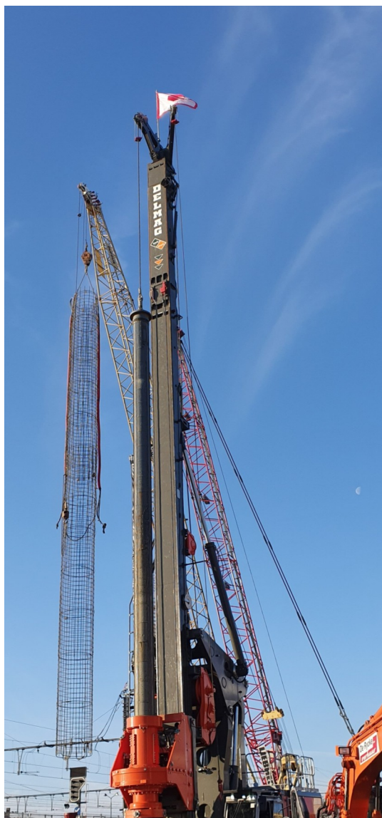
Inbouwen wapening in boorpaal van 10,0 tot 37,5 m diepte
