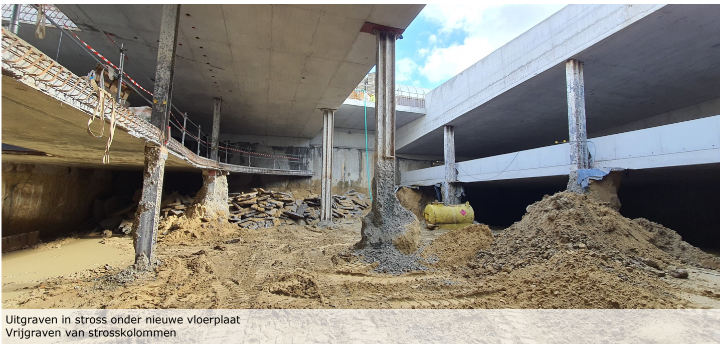
Betonneren paalvoet van 9,0 tot 37,5 m diep en recupereren boorbuis
